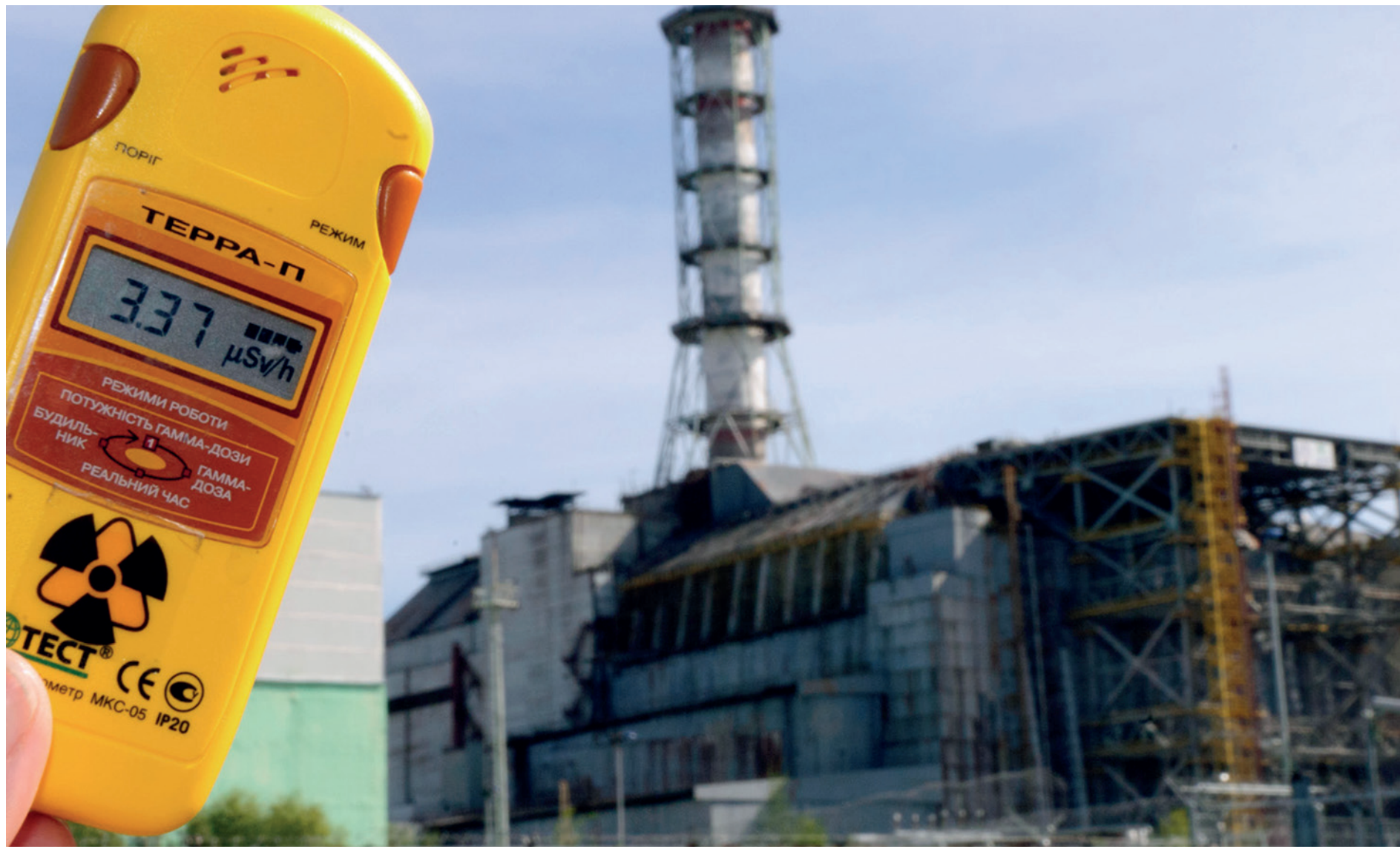
Der Katastrophen-Reaktor Nr. 4. Am 26. April 1986 wurde das 1.000 Tonnen schwere Dach durch die gewaltige Explosion angehoben, und das graphithaltige Inventar fing Feuer. Eine Wolke mit radioaktivem Rauch zog über weite Teile Ost- und Mitteleuropas. Foto: The Bellona Foundation / creativecommons.org/licenses/by-nc-sa/2.0
